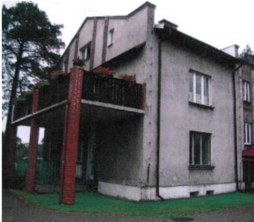
Fot. Widok istniejącego budynku mieszkalnego wielorodzinnego przy ul. T. Solonieiwcz 7 w Hajnówce
