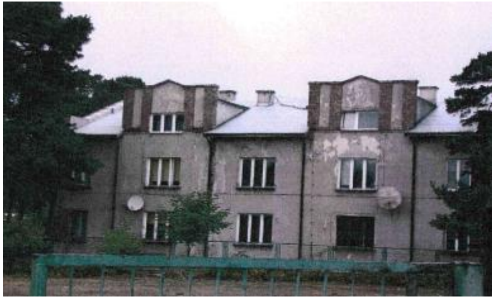
Fot. Widok istniejącego budynku mieszkalnego wielorodzinnego przy ul. T. Soloniewcz 7 w Hajnówce
